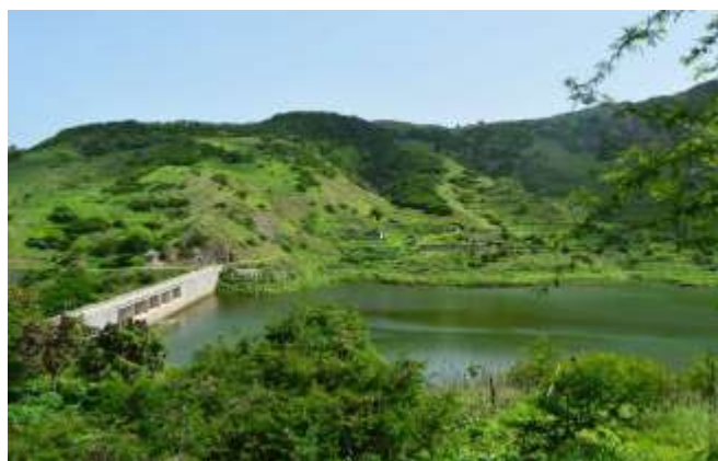
Figura 2 Barragem de Poilão - Cabo Verde
